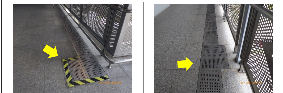
รูปที่ 2-17 รังระบายน้ำบริเวณสถานีรถไฟฟ้า
